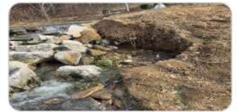
하천 제방 유실
